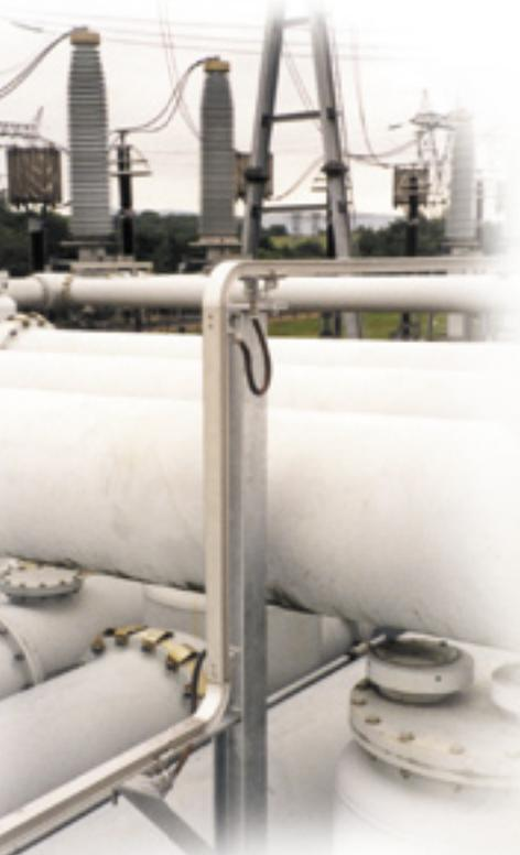
El sistema MultiRail puede ser instalado sobre tramos verticales que no sobrepasen 1 m.
